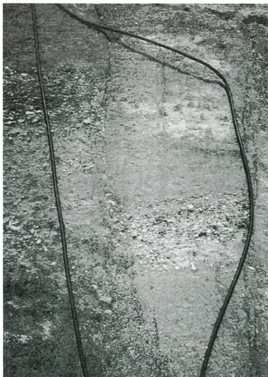
写真一 2 東海層群の中の断層（名古屋市緑区） 砂礫層にずれが見られる。
