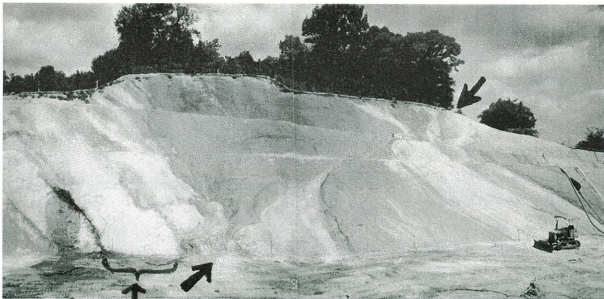
写真一 3 東海層群の中の断層（東海市） 加木屋断層近くの露頭、矢印が断層位置
