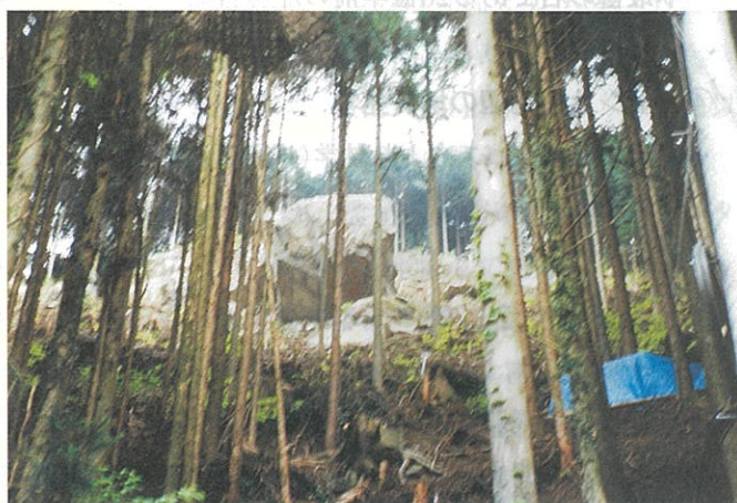
写真-3 下呂落石現場斜面上部にみられる巨礫
