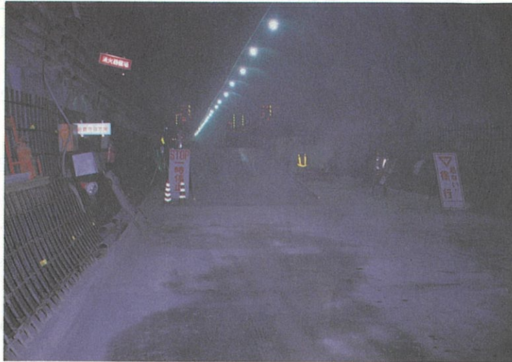
写真-4 400%インバート施工箇所上の栈橋
