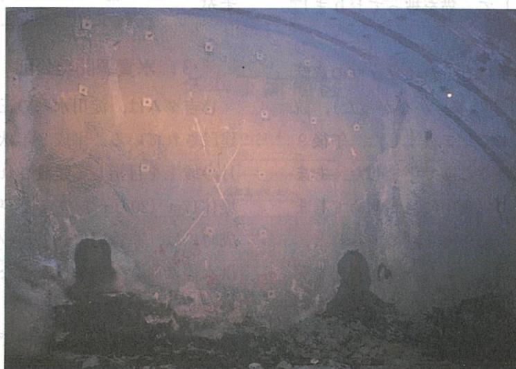
写真-6 切り羽面に施された吹き付けコンクリート
