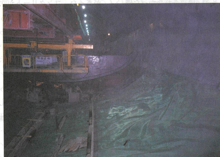
写真-3 インバート施工箇所
