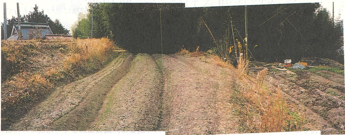
写真一六 地すべり地形頭部に発生したクラック（変位板の位置）。約60m連続する（Bタイプ）。
