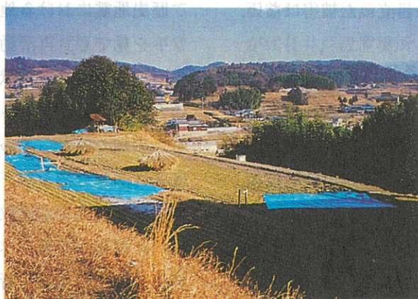
写真一七 Bタイプの頭部クラック（ブルーシート）。約50m円弧状に連続する。初生すべりタイプである。
