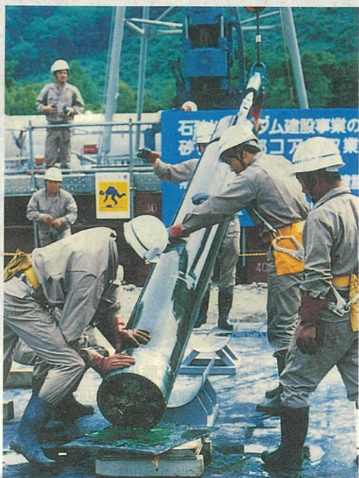
写真-1 サンプラーの引き上げ
