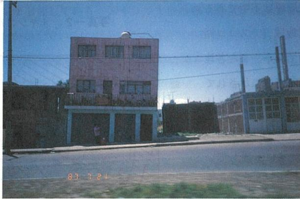
写真-3 地盤が軟弱なため傾斜した家屋
