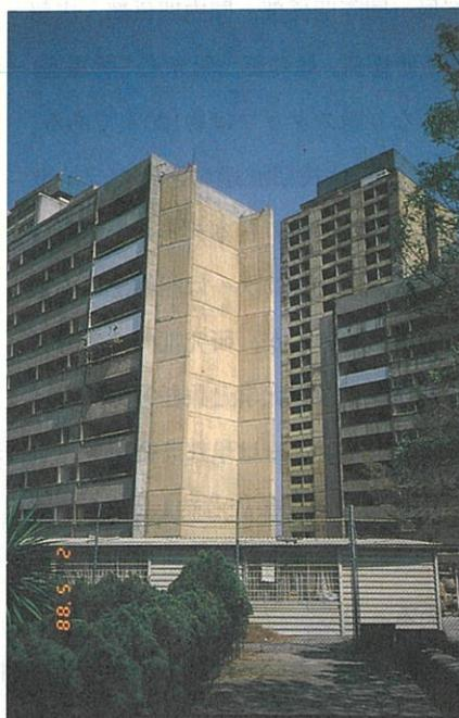
写真-9 側壁の補強
