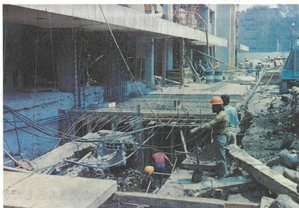
写真-11 地下1階部分の増設による足元の強化
