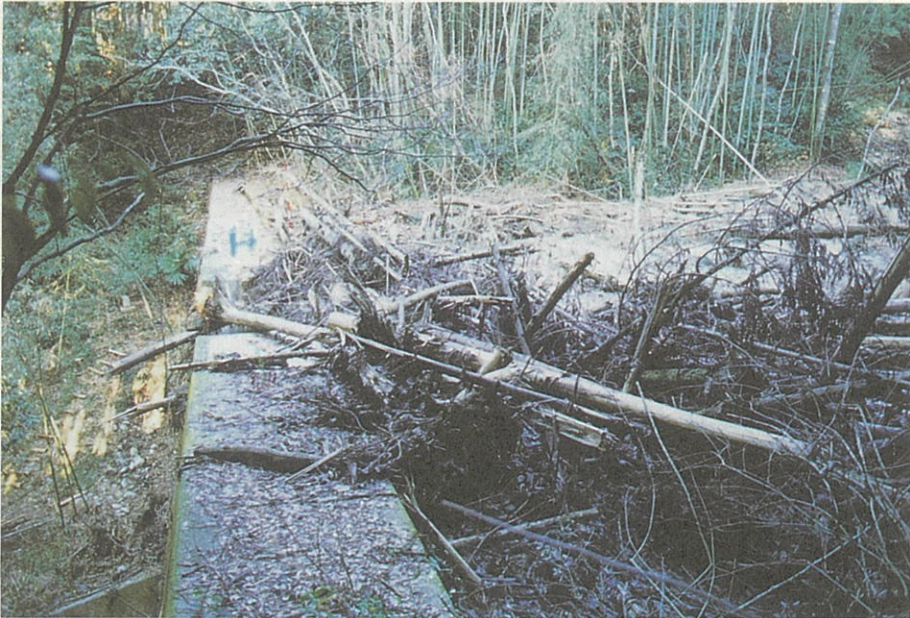
写真-2 下切沢 (砂防ダムによる土砂の捕捉状況)
