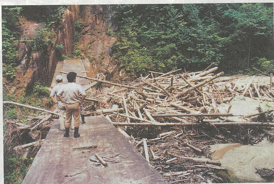
写真-4 竜宝寺川 (砂防ダムによる土砂の捕捉状況)
