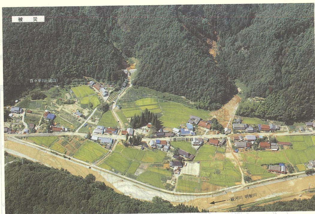
▲旭町大字須淵地内 中央の沢が下須淵川，上須淵川（右の沢）は砂防施設がなく被害が発生している。
