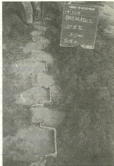
写真-8 鋼矢板打込後跡埋め（川砂使用）
