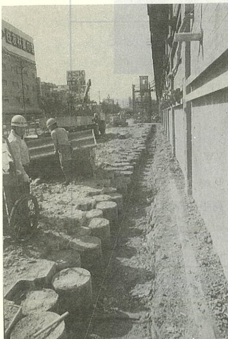
写真 - 9 ONS 完了状態
