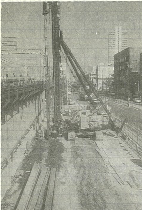
写真-7 鋼矢板打込工
