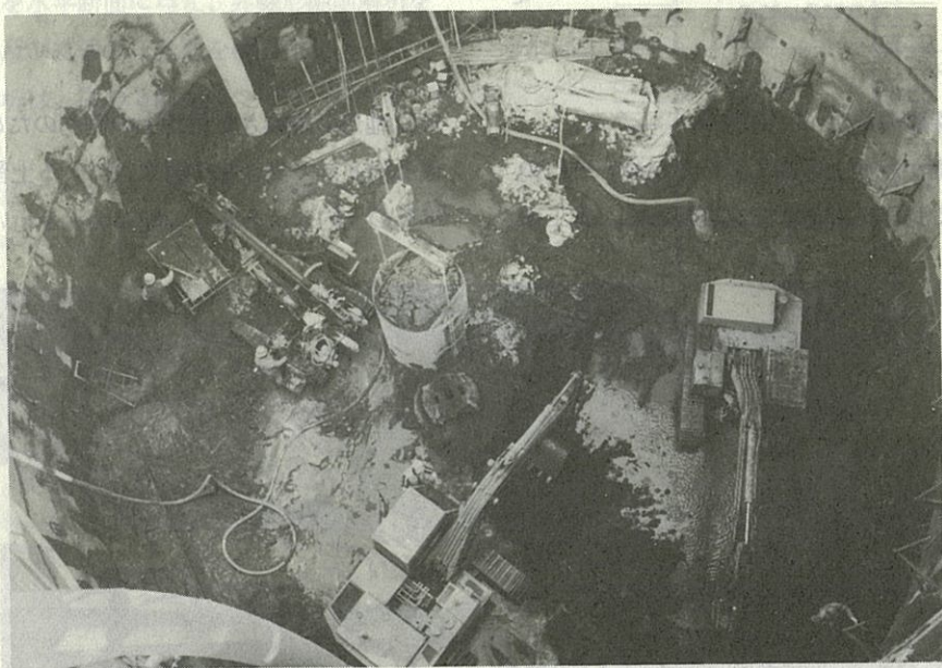
写真-3 大口径深礎の掘削状況
