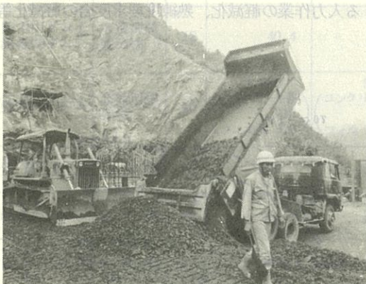
写真-4 コンクリートの打込み状況
