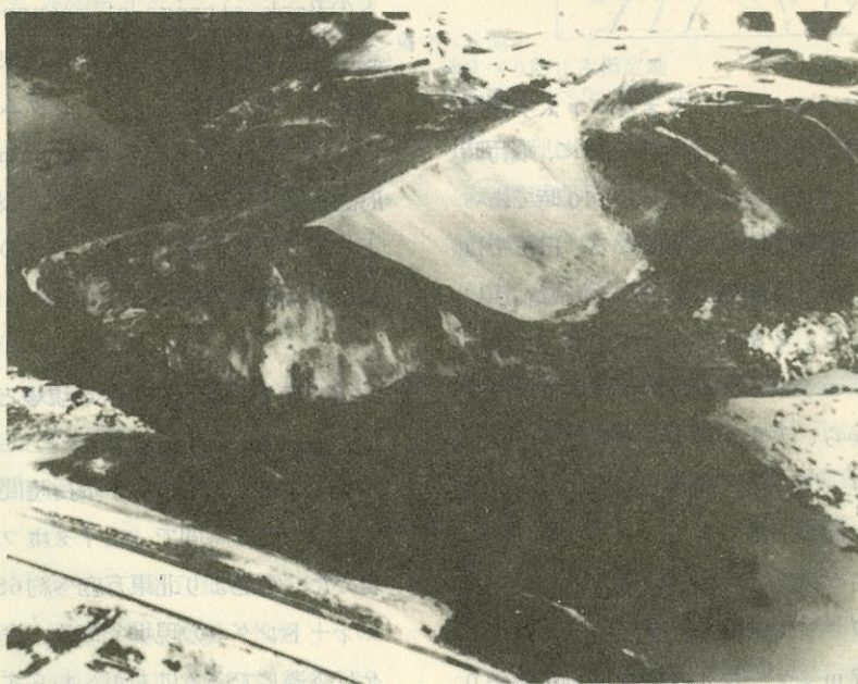
b. 決壊後 昭和51年6月撮影（右岸側の堤体が約40%にわたって崩壊している。）
