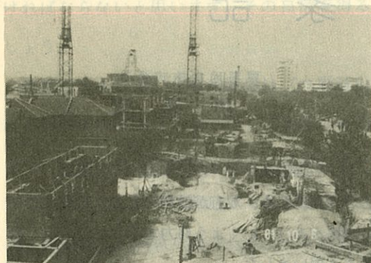
建設中のアパート 天津市
