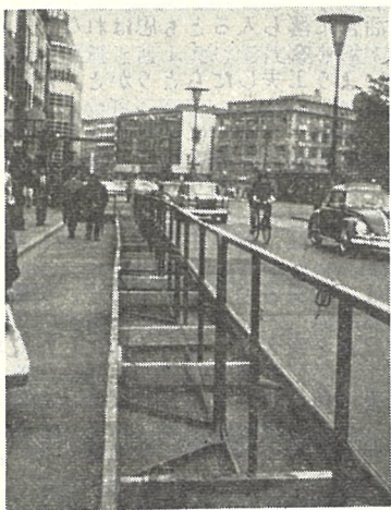
フランクフルト。仮設歩道
