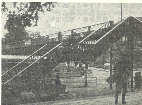
フランクフルト横断橋。地下鉄工事のための仮設歩道橋
