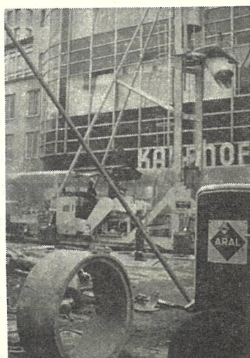
ドイツ地下鉄現場。百貨店前の工事現場
