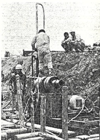
写真～6 エクスフロー ラのロット継 ぎ足し作業
