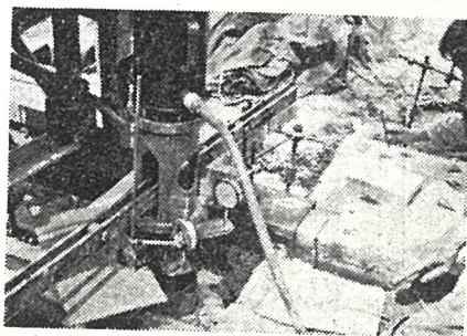
写真(2) オイルジャッキ及沈下量測定装置
