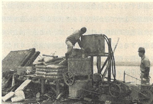
ブランチャー式グラウトポンプ 海岸樋門グラウト工事中
