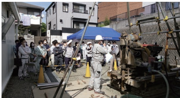
ボーリング作業見学会の状況
