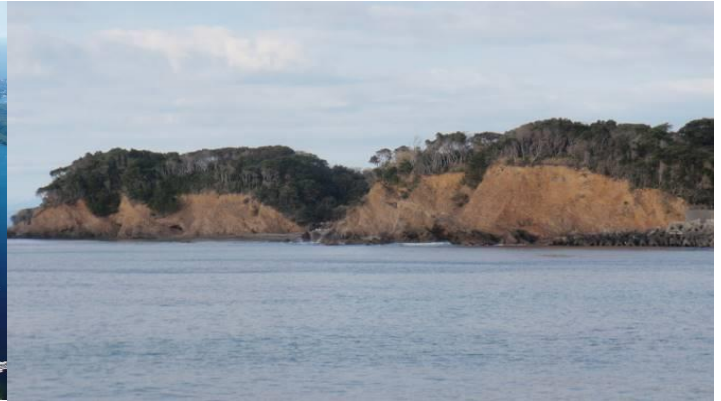
写真-2 先志摩半島(太平洋側)の海岸崖
