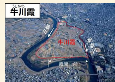
豊川霞堤地区浸水被害軽減対策協議会資料より
