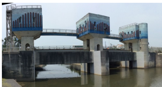
写真-2 河口にある大谷川水門
