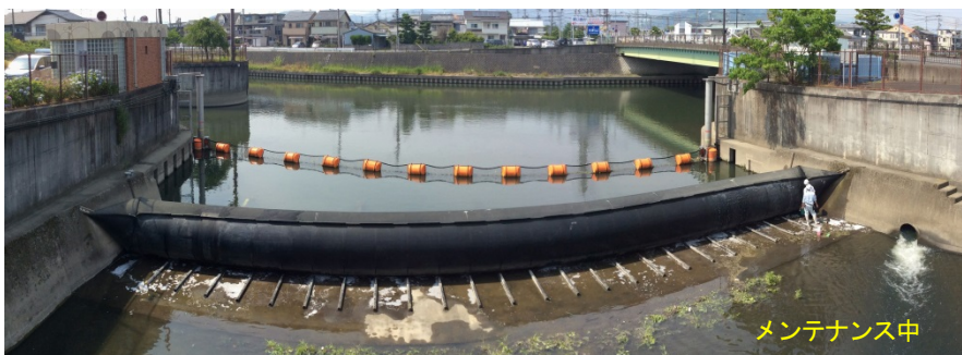
写真-1 古庄分流堰(ゴム堰)
