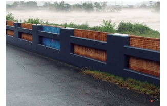
西日本豪雨の翌朝の揖保川の畳堤（ミツカン水の文化センターHPより）
