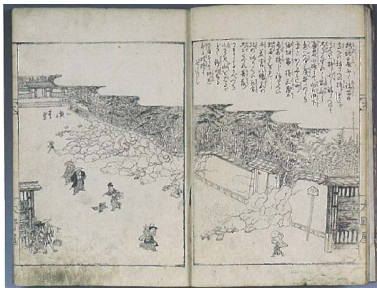
倒壊した練り堀の様子 （愛知県史別編 自然より）
